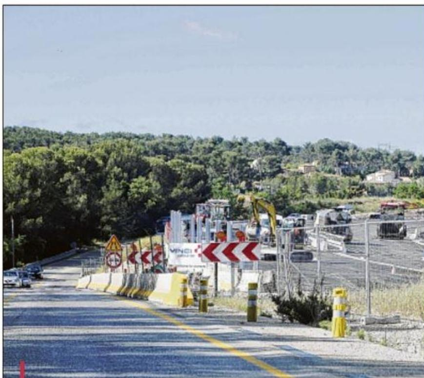
Les travaux de la D9 se poursuivent et avancent à grands pas. Mi-juillet, les voitures rouleront sur la nouvelle route (ici à droite) mais sur 1X1 voie le temps de terminer les deux autres voies dans l'autre sens. La circulation sur les 2X2 voies, ce sera pour décembre.
